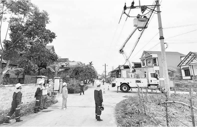
Đội sửa chữa điện hotline tham gia diễn tập khắc phục sự cố điện tại xã Tân Cương (TP. Thái Nguyên).
