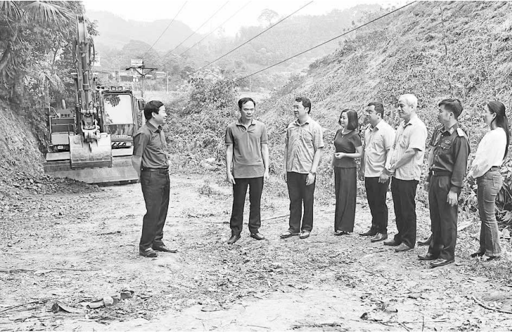
Các đồng chí lãnh đạo huyện Phú Lương và nhân dân xóm Ba Họ tại buổi khởi công tuyến đường.
