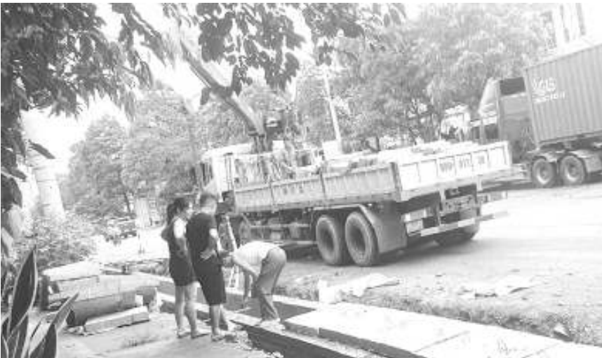
Nhà thầu đang tích cực thi công để đảm bảo tiến độ Dự án.
