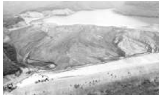
Mỏ sắt Tiến Bộ thực hiện gia cố các hạng mục của đập quặng đuôi trước mùa mưa bão.
