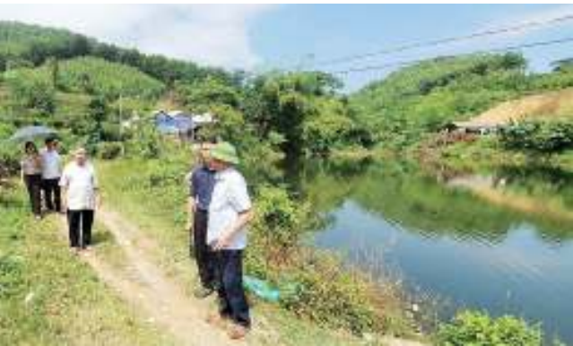
Chính quyền địa phương và người dân kiểm tra trực tiếp tại công trình hồ Cúc Lùng, xã Phú Đô.
