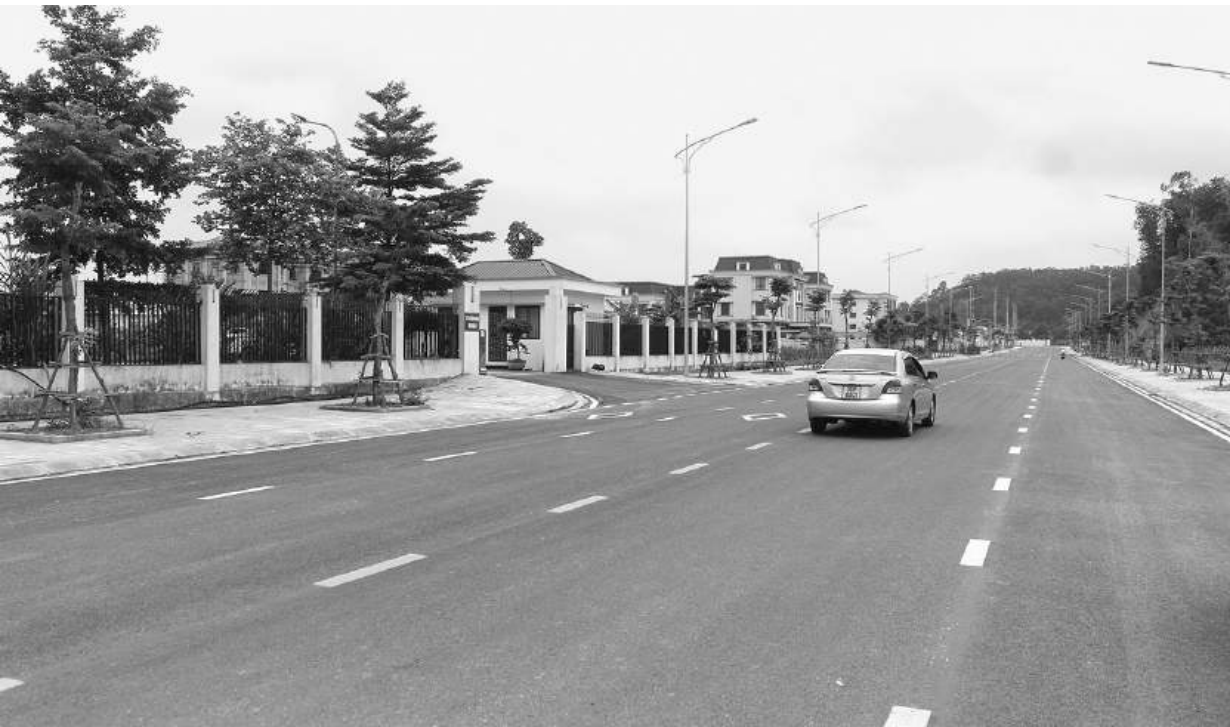
Kết cấu hạ tầng khu hành chính mới huyện Đồng Hỷ được đầu tư xây dựng ngày càng khang trang, đồng bộ.
