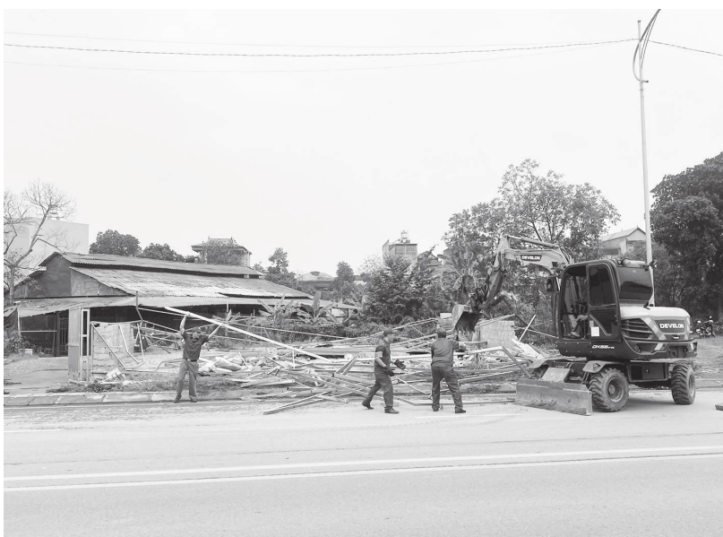
Lực lượng chức năng tiến hành cưỡng chế tháo dỡ công trình xây dựng trái phép trên đất công do UBND phường Gia Sàng quản lý.
