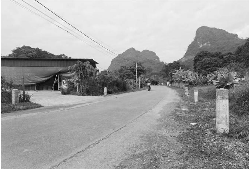
Tuyến đường từ xóm Đồng Dong đi khu vực Lân Thùng, xã Phương Giao (Võ Nhai) được mở rộng nhờ người dân hiến đất.
