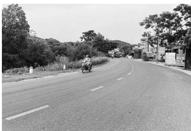
Tuyến đường tỉnh 261 đoạn qua thị trấn Quân Chu (Đại Từ) được đầu tư mở rộng.
