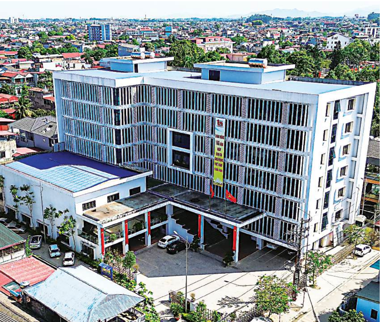
Một cơ sở của Báo và Phát thanh, Truyền hình Thái Nguyên tại số 19, phố Nhị Quý, phường Phan Đình Phùng.
