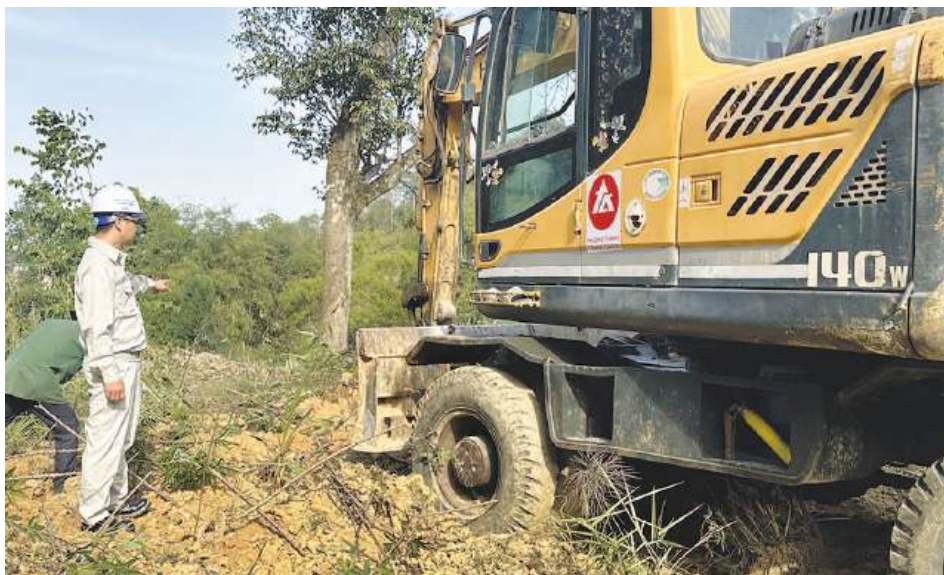
Công ty cổ phần Đầu tư và Xây dựng Phương Thành triển khai mũi thi công trên tuyến cao tốc Chợ Mới - Bắc Kạn.
